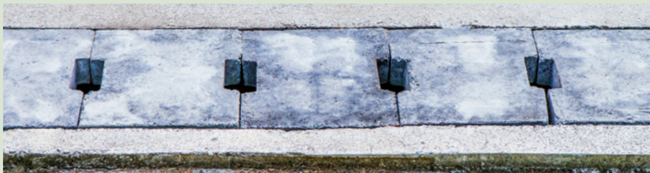
Figura 37. Esempio di caditoia filtrante a bordo strada.
