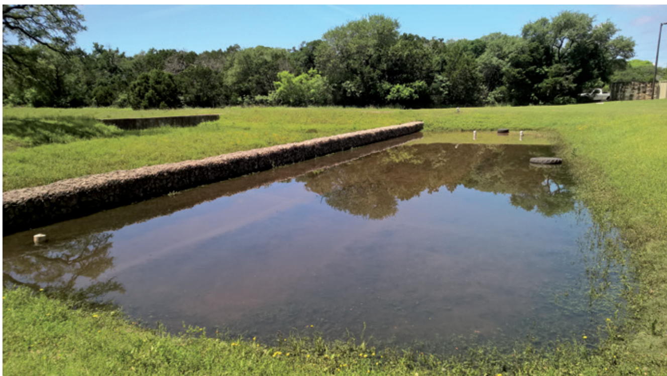
Figura 45. Esempio di un piccolo bacino di infiltrazione riempito dopo una precipitazione intensa.
