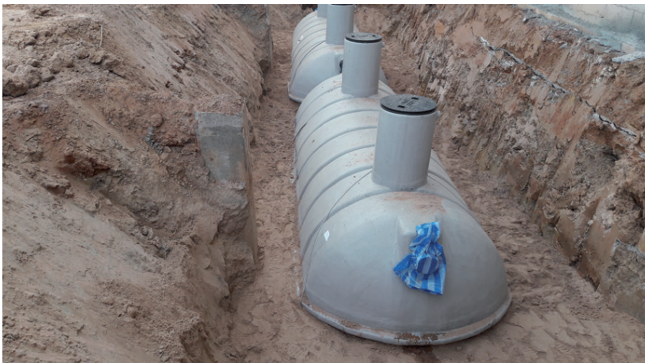
Figura 26. Esempio di installazione di una cisterna sotterranea per la raccolta delle acque piovane.
